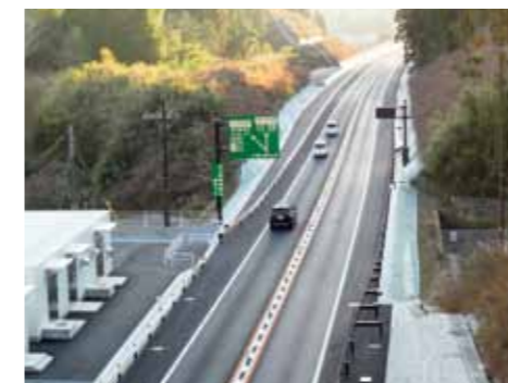
12月15日開通の延岡～北川間（小峰町）
