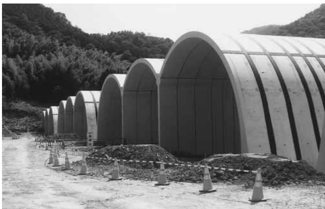
宇和田地区のアーチカルバート工事
